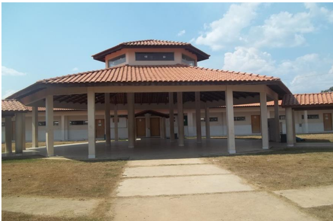
Autor: Emílio Sarde Neto. Aldeia Kyowã 2013. A Escola Indígena de Ensino Fundamental e Médio Kyowã , construída em 2011 toda em alvenaria pela empresa Santo Antônio Energia.
